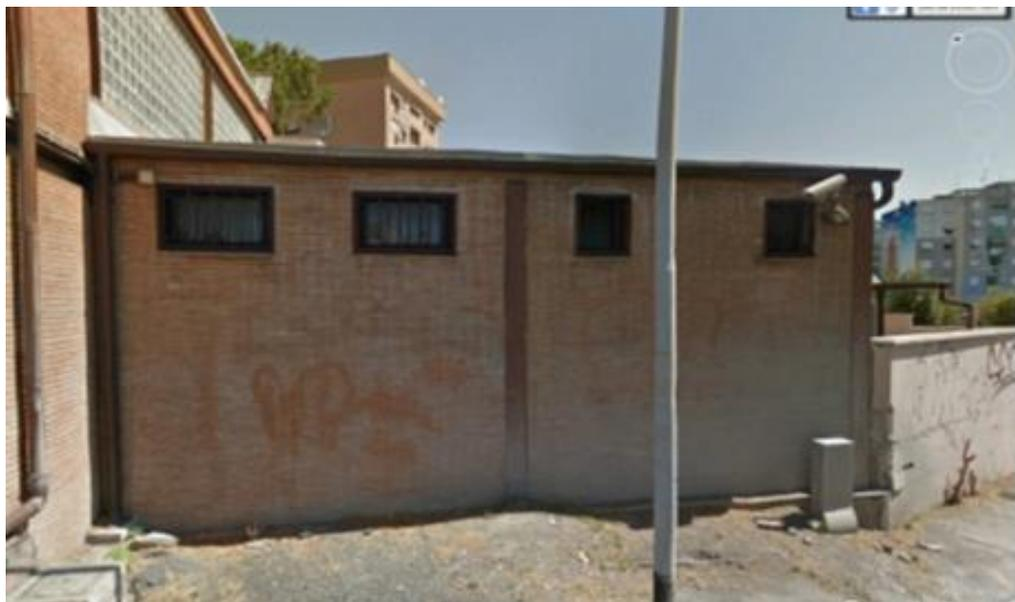
Il terzo tratto è il più importante. È anch'esso in mattoncini sabbiati e misura circa 29 metri di lunghezza per 5 metri di altezza. Il muro inoltre è diviso in cinque parti da pilastri di metallo, affiancati in tre casi da discendenti per lo scorrimento delle acque pluviali.
